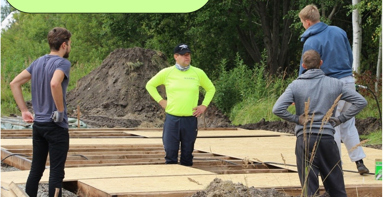
Sport on osa kultuurist. Abilinnapea Marko Šorin lõi sintlasena käe külge Sindi vana staadioni renoveerimistööl 2017. Alumisel fotol (kollases särkis keskel) on ta vabatahtlikuna abiks jalgpalliklubi Poseidon liikmetel jalgpallistaadioni tribüüni ehitamisel ja ülemisel pildil on tal käsil puitkarkassi loodimine. Fotod erakogust
